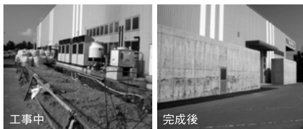
写真2 遮音壁の工事
