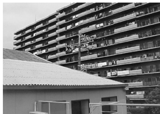
写真1 道路を隔てて建つマンション
